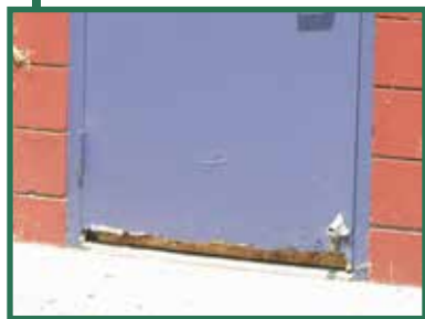
Cửa lớp học với thối khô cần phải được thay thế vì sự an toàn và hiệu quả năng lượng.
